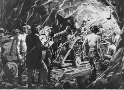
Darstellung einer Inspektion der Bauunternehmers Louis Favre an der Tunnelbrust um 1900. (Bilder: Slg. VHS)
